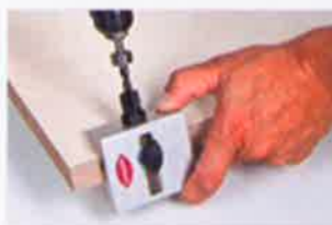
Die Bohrlehre wird in die Nut geschoben und die Bedienungsöffnung gebohrt.
